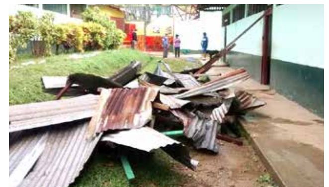
Vientos en Cajamarca ocasionaron que 12 familias se queden sin casas.
